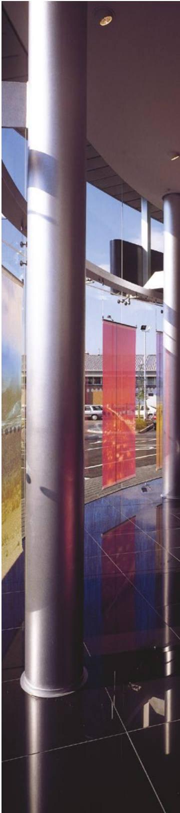
Système SGG POINT S pour verre feuilleté.
